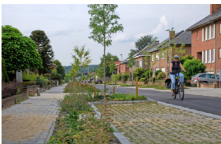
Frans Nackaertsstraat, Kessel-lo
